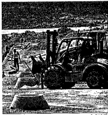
Imagen de las obras del PITA. R. GARCÍA
