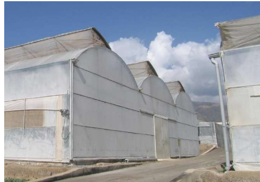
Figura 4. Invernadero con ventilación lateral y cenital
