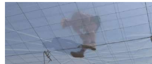
Imagen 8. Reparación del plástico
