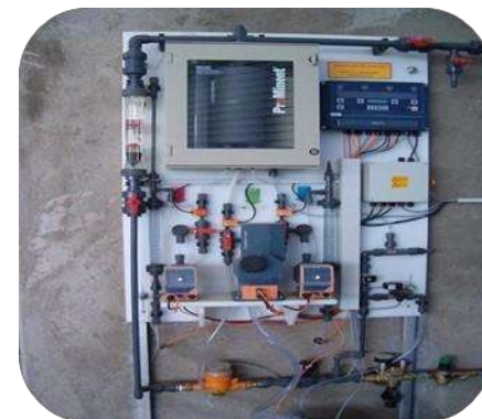
Apparatuur voor het genereren van chloordioxide.
