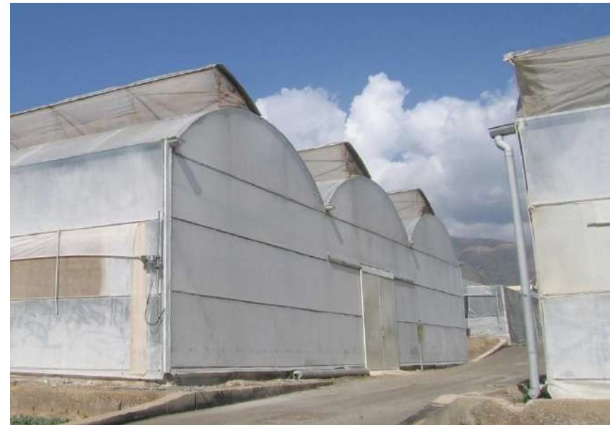
Figuur 4. Kas met zijdelingse en zenitale ventilatie
