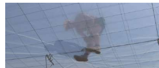
Afbeelding 8. Reparatie van het plastic
