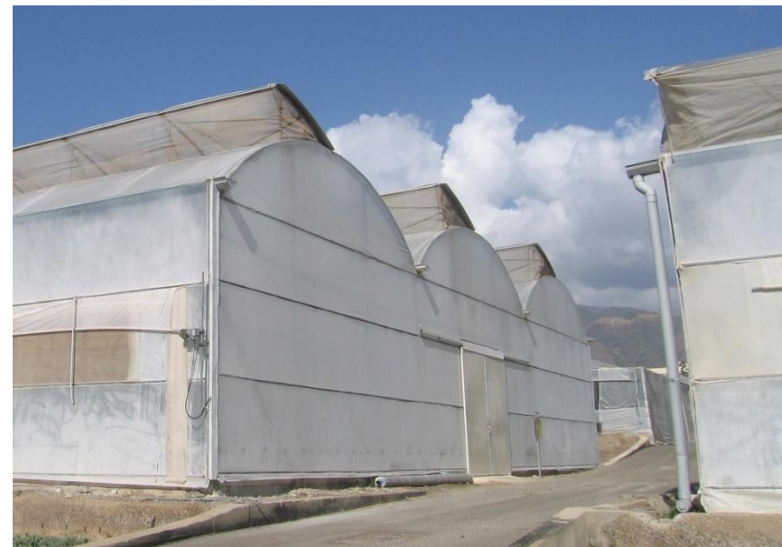
Figura 4. Seră cu ventilație laterală și zenitală
